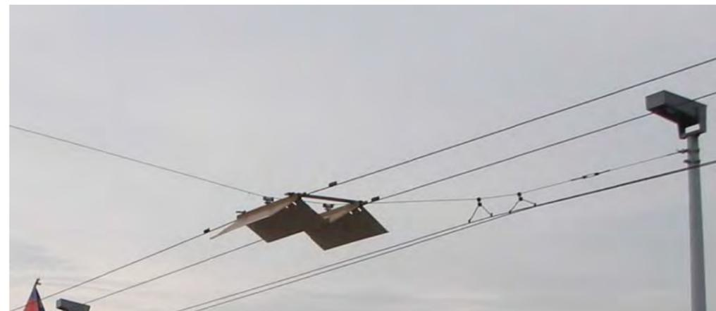
Figure 18 : Photo guide d'emperchage LAC Trolleybus – zoom - Lyon
