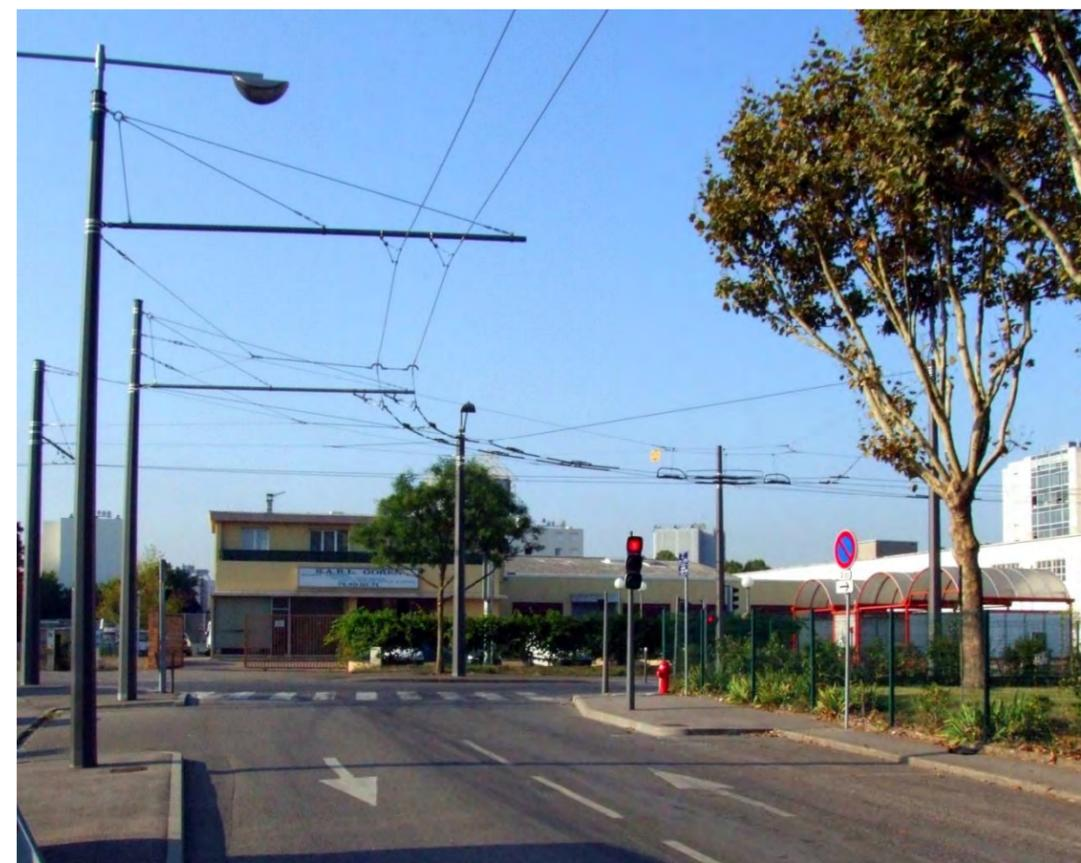
Figure 9 : Photo exemple LAC Trolleybus site mixte – Lyon – accrochage sur poteaux
