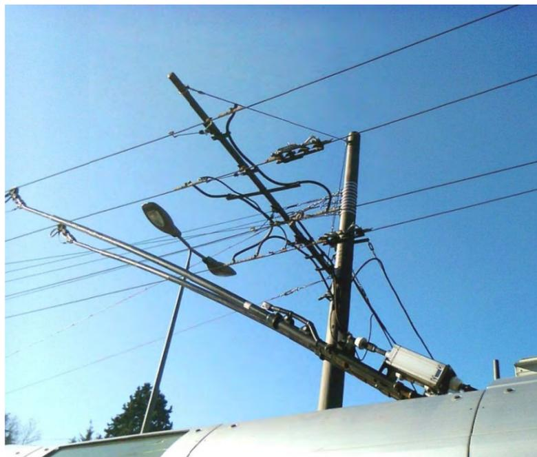
Figure 16 : Photo insertion alimentation et isolateur de section LAC Trolleybus - Lyon
