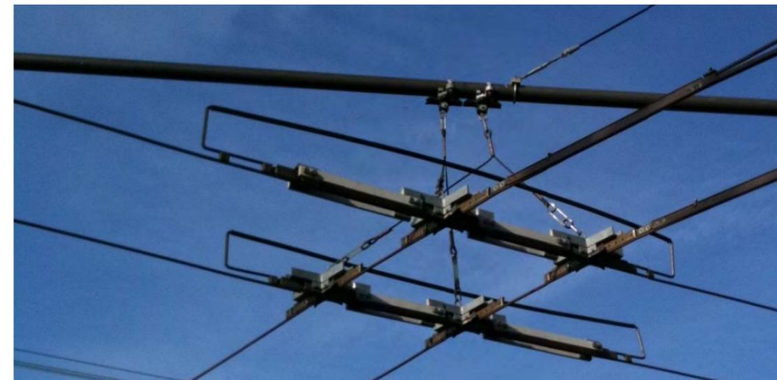
Figure 14 :Photo appareil de croisement de 2 LAC Trolleybus - Lyon
