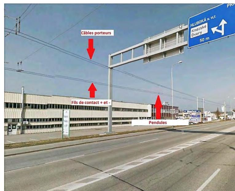
Figure 8 : insertion LAC Trolleybus type caténaire pour maximiser la portée entre 2 supports – Ceské Budejovice
