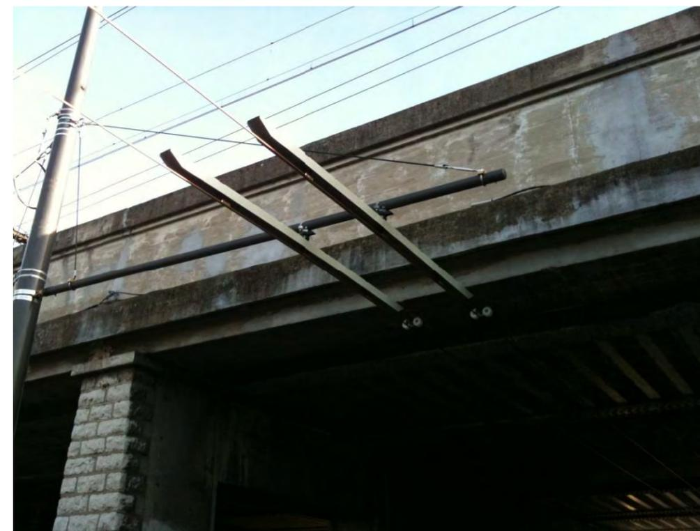
Figure 12 :Photo passage sous ouvrage LAC Trolleybus - Lyon
